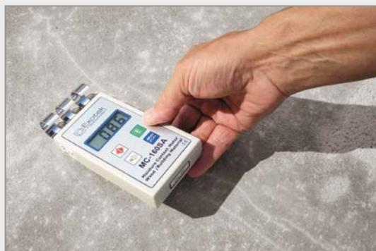
**Рис. 3.2.1.** Проверка влажности основания.
