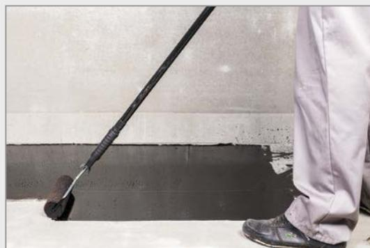
**Рис. 3.2.2.** Нанесение праймера.
